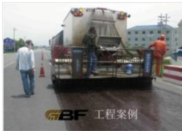
GBF纤维在公路养护
